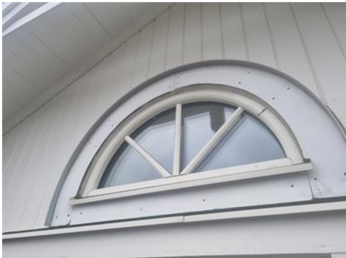
Exempelbild, halvmånefönster med rötskador/underhållsbehov i dess foder/salningar.
