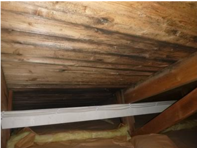
Vindsutrymme (ursprunglig del)
