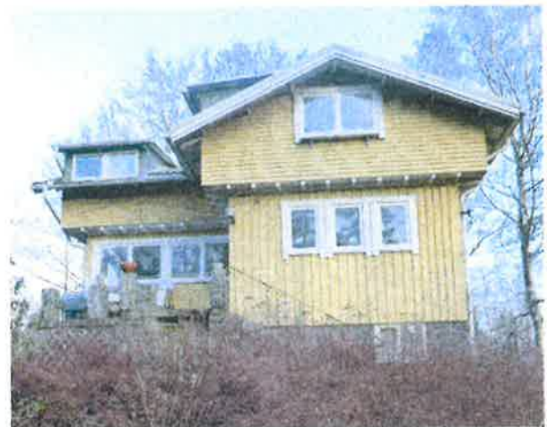
Annexet, fasad mot väst.
