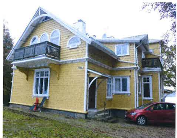
Villa Waldesruh, fasad mot syd.
