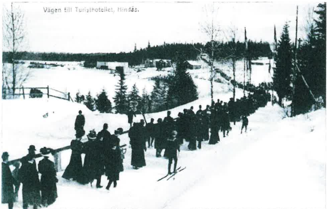
Hindås stationsväg i början av 1900-talet som visar strömmen av resande på väg till Turisthotellet. Vägen har samma sträckning som idag. Källa: Gamla bilder berättar, del 1.
