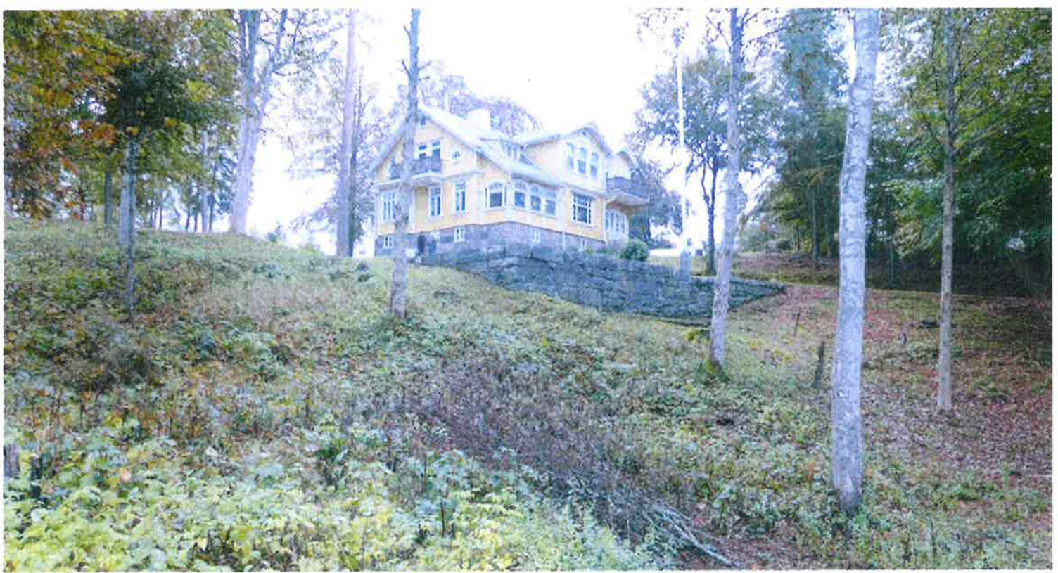
Vy mot Waldesruh från Hindås stationsväg. De obebyggda sluttningarna har rikligt med markvegetation och träd, vilket ger tomten en naturkaraktär. Här syns även en ursprunglig terrassmur av granit.
