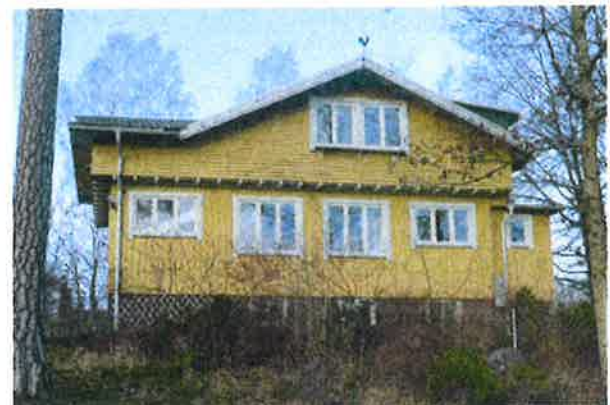
Annexet, fasad mot syd.
