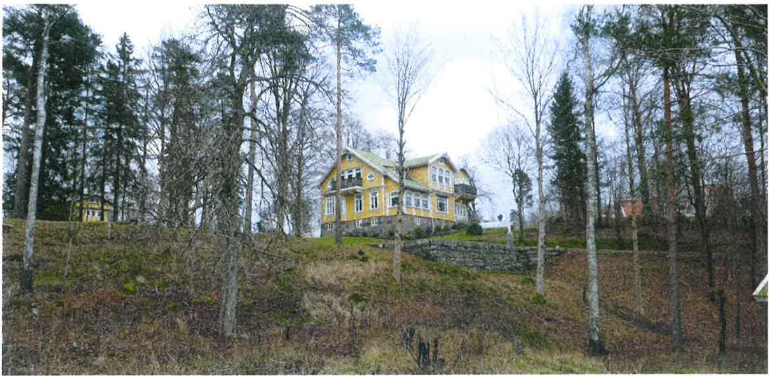
Vy mot Waldesruh från Hindås stationsväg. De obebyggda sluttningarna utgör en väsentlig del i kulturmiljön och speglar tidens trädgårdsideal och vurm för naturen.
