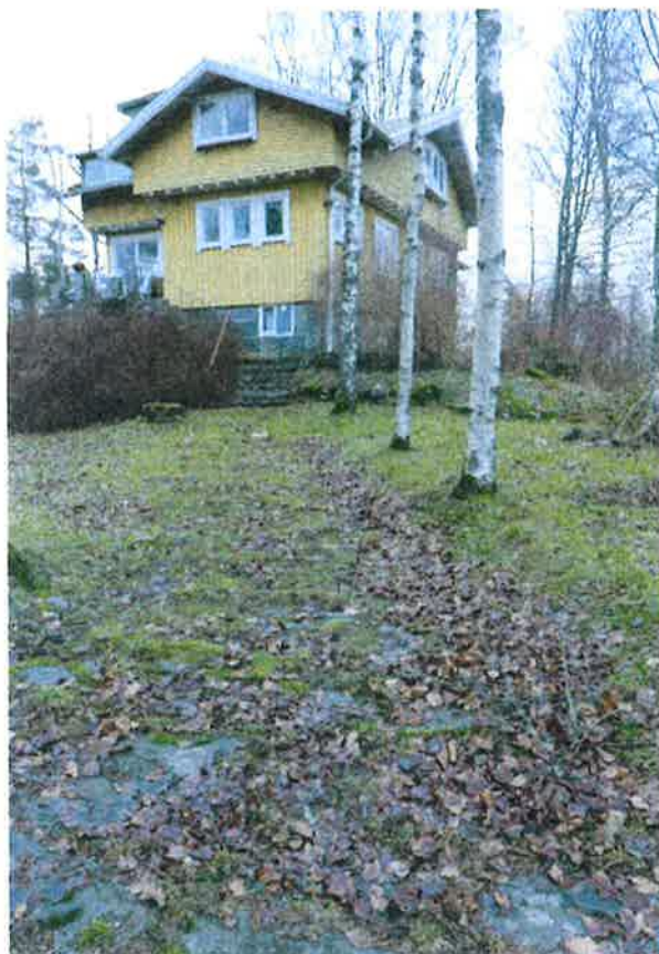
Stensatt gångstråk mot Annexet.
