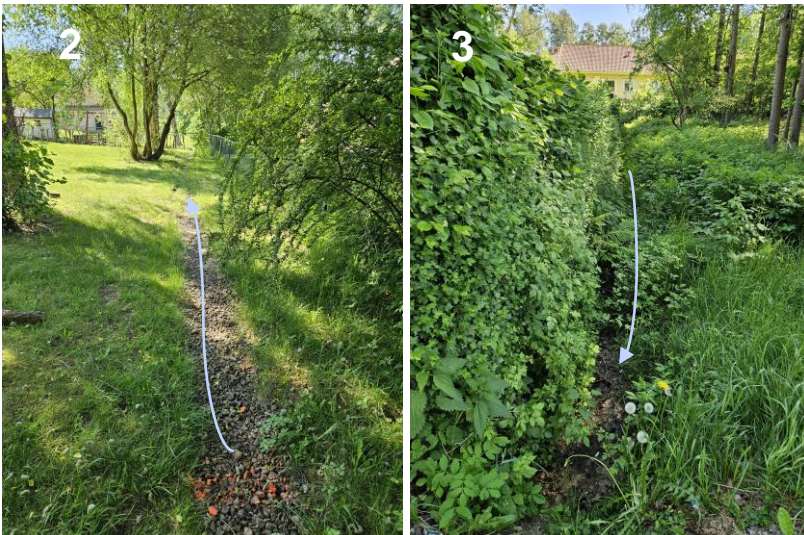
Figur 8 Dike längs grannfastigheterna. Bild till vänster: makadamfyllt dike vid Gårdsten 24:6. Till höger: diket längs Gårdsten 24:7 precis uppströms trumman under Kronorättarens väg.
