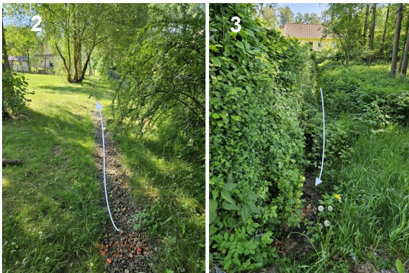
Figur 8 Dike längs grannfastigheterna. Bild till vänster: makadamfyllt dike vid Gårdsten 24:6. Till höger: diket längs Gårdsten 24:7 precis uppströms trumman under Kronorättarens väg.
