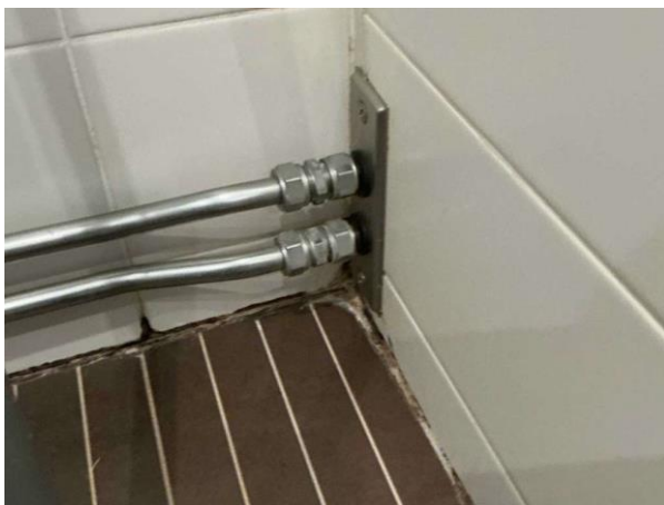
Bild 4: Invändigt, Souterrängplan, Badrum, Det förekommer rörgenomföring i vägg i duschzonen Missfärgade fogar
