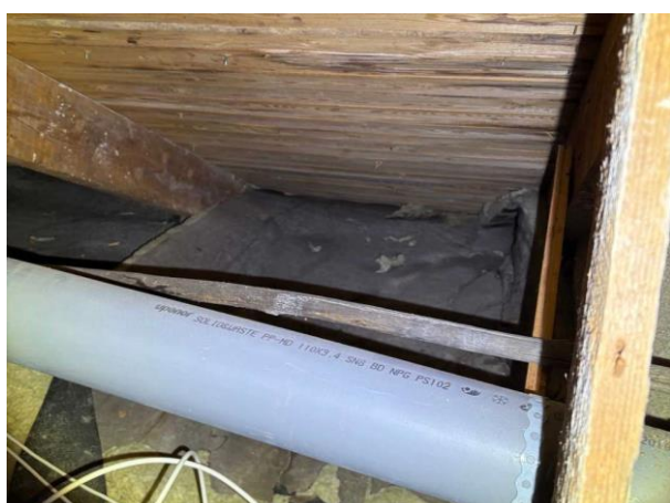
Bild 5: - Utvändigt, Vind, Huset är självdragsventilerat, se riskanalysen Lokalt noterades Mikrobiell påväxt.
