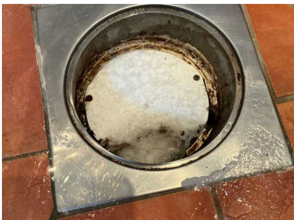
Bild 1: - Invändigt, Souterrängplan, Kvalitetsdokument saknas Golvbrunnen är väggnära placerad Golvbrunnen är inte utbytt och klämri...
