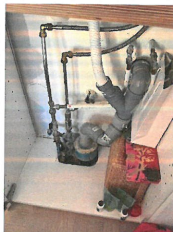
Bild 4: - Invändigt, Entréplan, Inbyggda vattenkopplingar saknar bakomliggande tätskikt Frånluft i rum istället för tilluft
