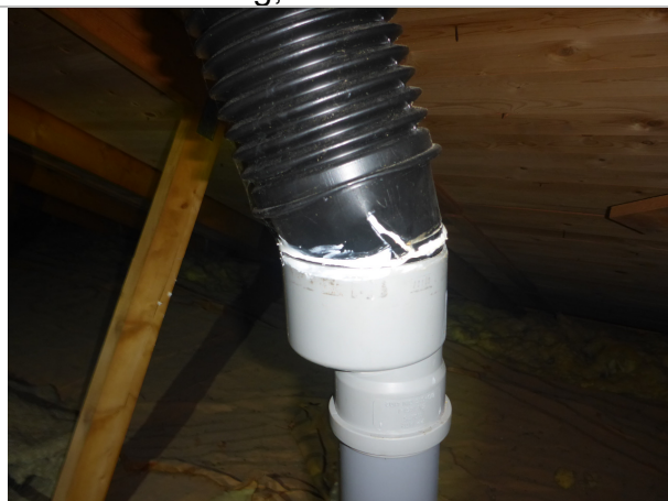
Vind/avluftningsrör.
