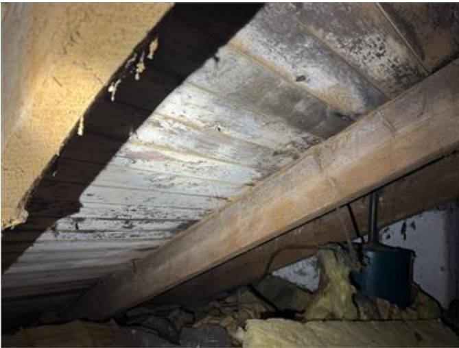
Bild visar mikrobiell påväxt mot underlagstak.
