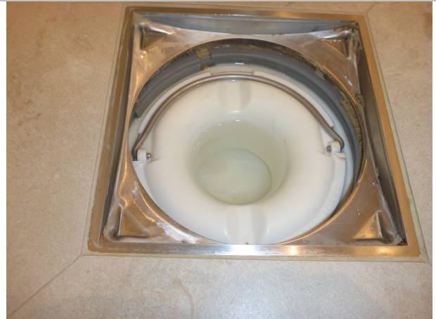
Dusch öv, golvbrunn.
