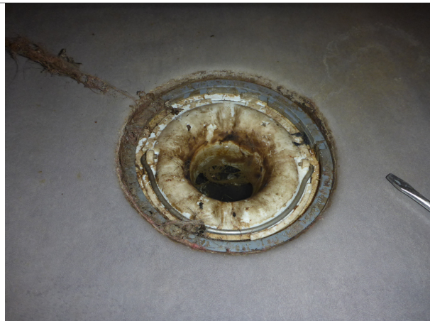
Dusch kv, golvbrunn.
