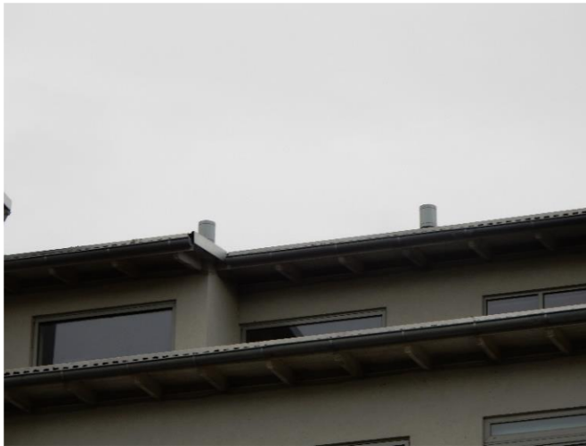
Bild 16 Avluftningshattar på taket
