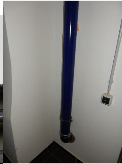
Bild 17 Avloppsstam med dimension 110 mm
