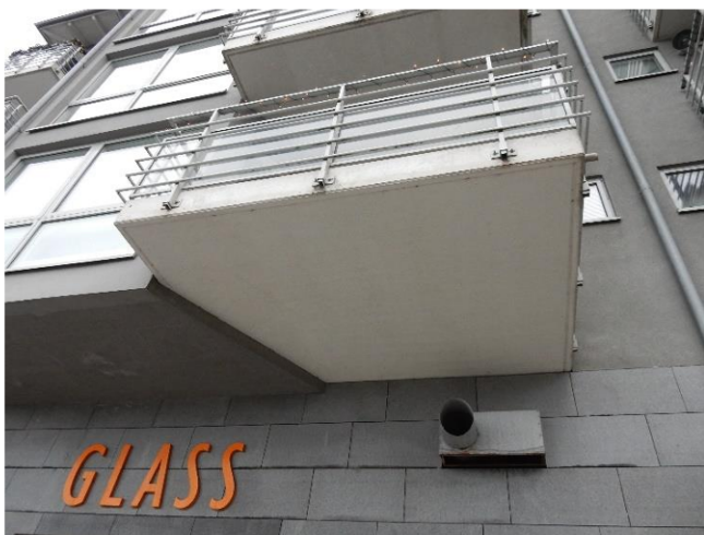
Bild 6 Balkong av prefabricerad betong
