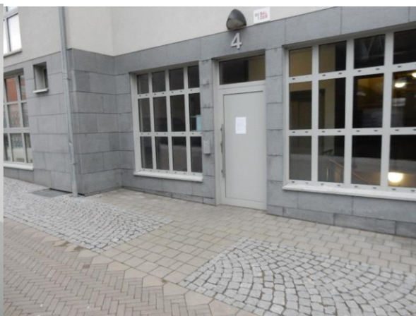
Bild 8 Ståldörr till lokaler
