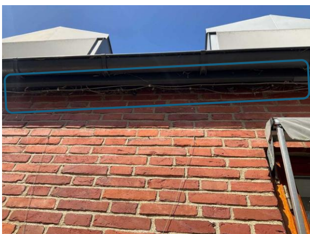
Bild 3: Utvändigt, Övrigt, Noterades att växtlighet tidigare kommit upp och in mot takfot på några delar.
