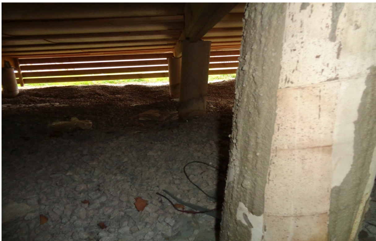
Bild på lutande plintar samt att papp sitter kvar.
