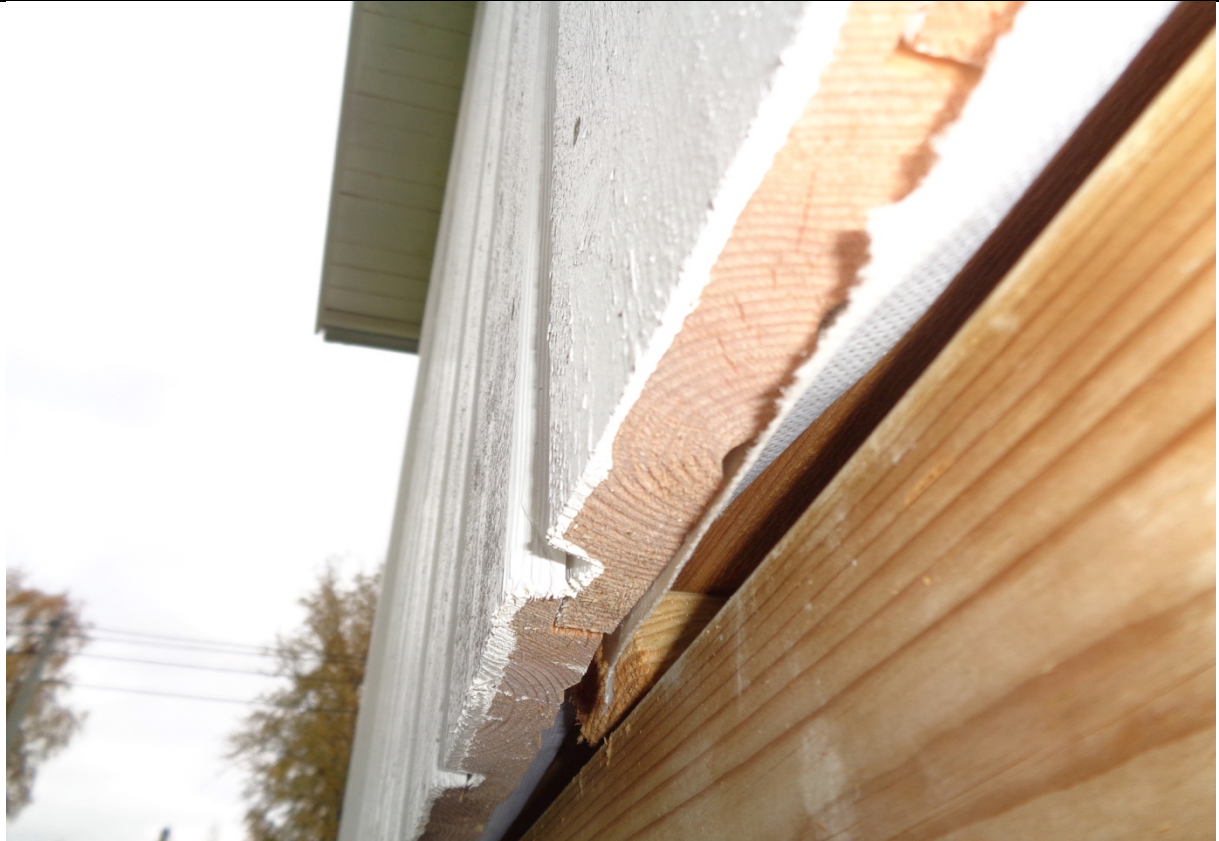
Bilden visar omålade panelbrädor i underkant.
