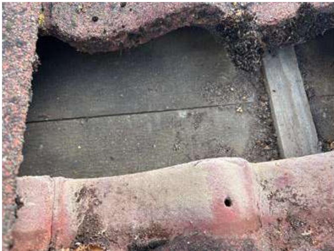
Stickprovsmässig kontroll av läkt och undertak under betongpannor, utan anmärkning.
