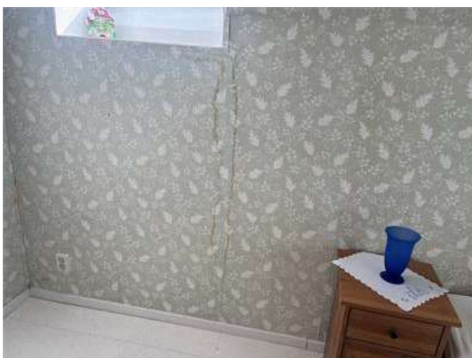
Missfärningar under takfönster (inga förhöjda fuktindikationer vid besiktningstillfället)
