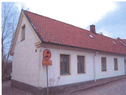
Fasad mot Gamlebygatan
