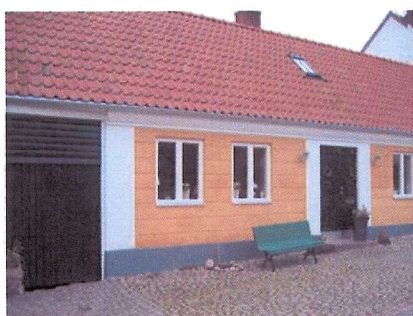
Fasad mot Gamlebygatan
