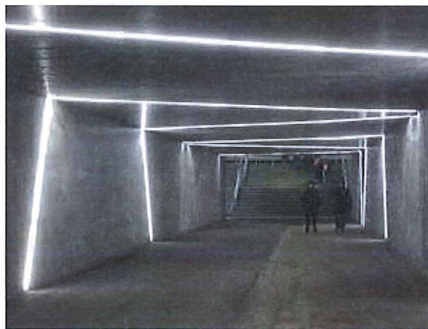
Bild 10. Gångtunnel vid Båstads nya station.
