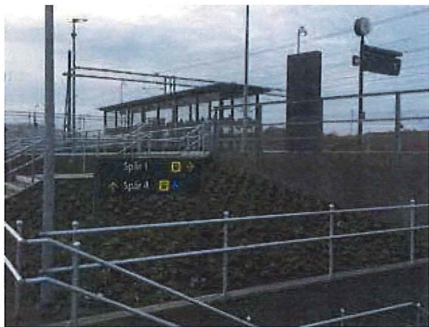
Bild 9. Plattform och väderskydd vid Båstads nya station.
