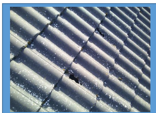
Skador/brister yttertak
