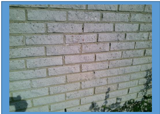
Förslitningsskador tegelfasad
