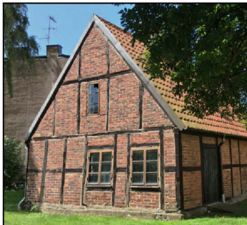
Oregelbundenheter, skevheter och sättningar som inte är skadliga för konstruktionen ger karaktär. Original-/äldre fönster i gavelröste är bevarat, se q.
