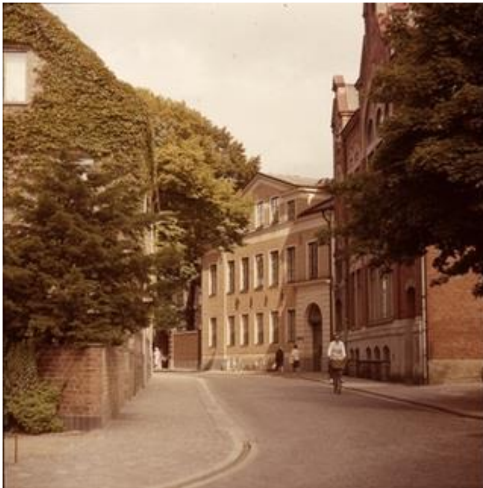
Tidigare mur i fastighetsgräns troligen uppförd på 1940-talet (Hagbloms foto troligen före 1967. Källa UB).
