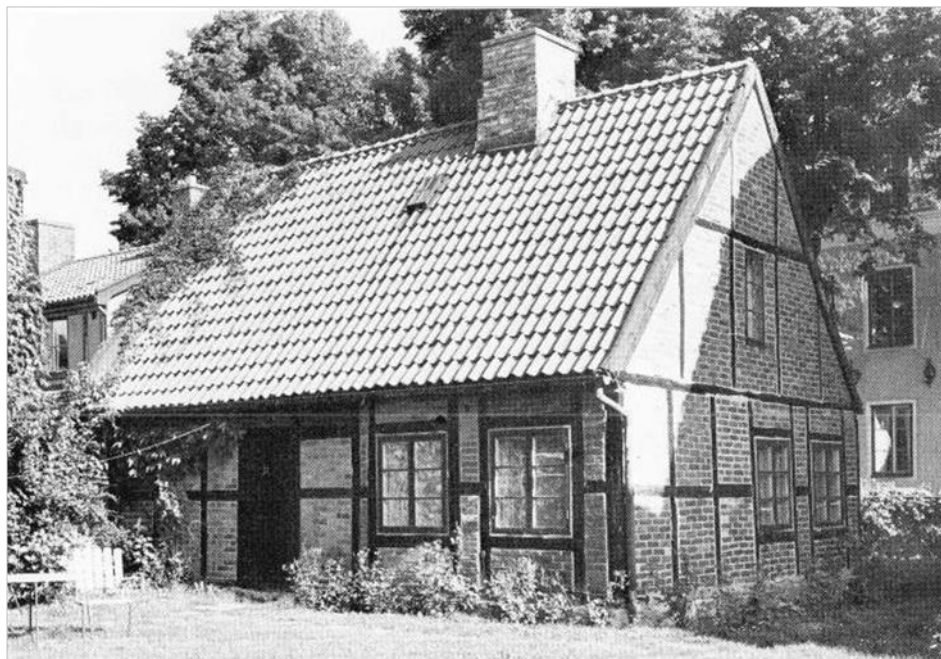
Korsvirkehuset är den äldsta byggnaden på fastigheten, men är idag inte i bruk.
