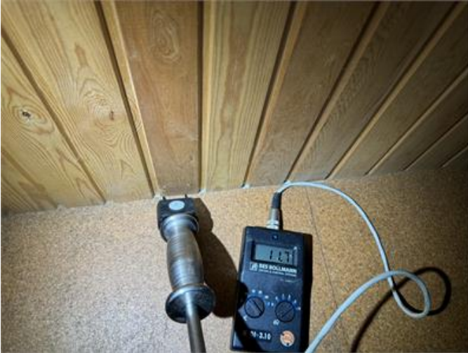
Fuktkvotsmätning i utreglad vägg bastu.
