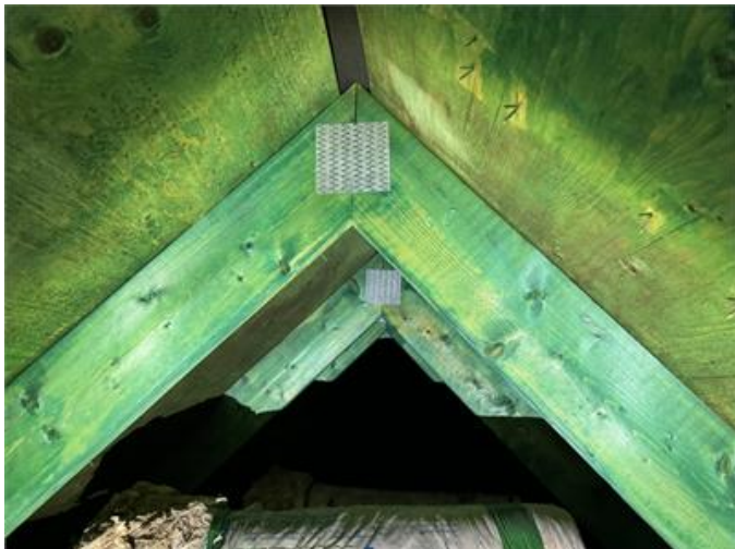
Bild tagen på nockvind.
