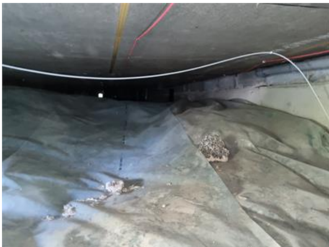
Bild från krypgrunden
