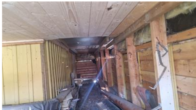
Bilden visar grunden under tillbyggnad
