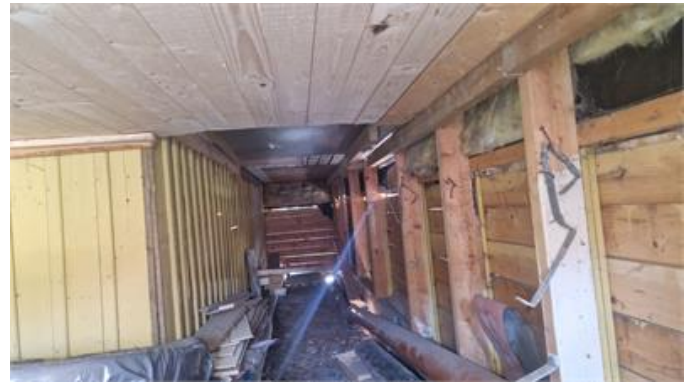
Bilden visar grunden under tillbyggnad
