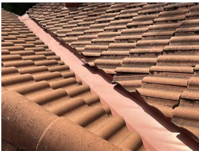
Bild visar del av taket.
