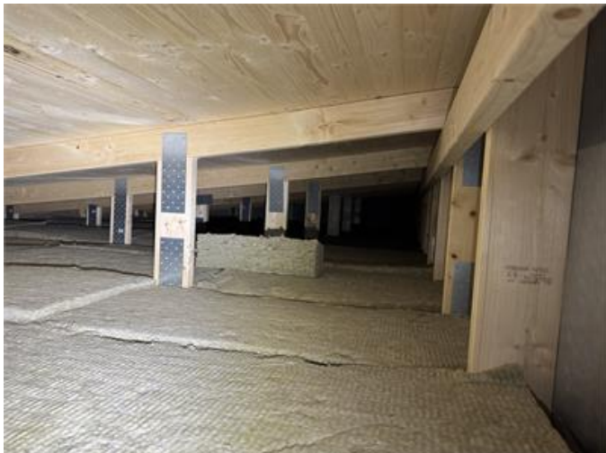
Bild visar vindsutrymmet på tillbyggnaden.
