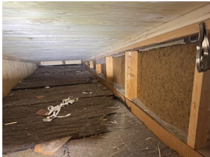
Bild tagen på vindsutrymmet.
