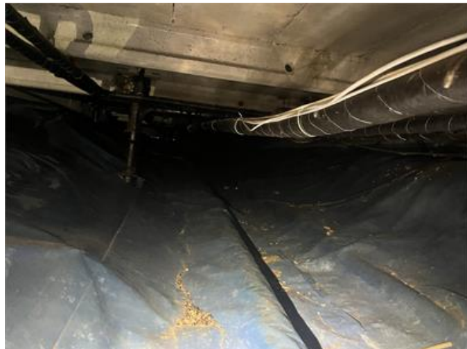
Bild från krypgrunden
