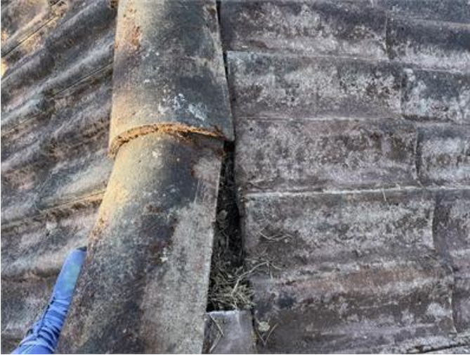
Bild tagen vid besiktning av yttertak.
