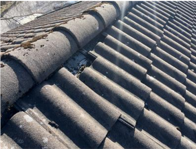
Bild från taket.
