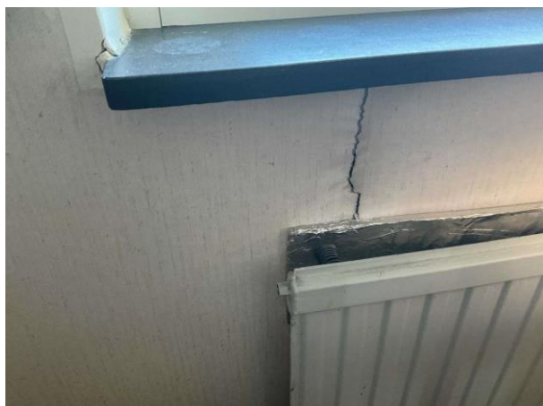
Bild 1: Invändigt, Entréplan, Sovrum 1, Ordnad tilluft saknas Rörelse spricka noteras på yttervägg
