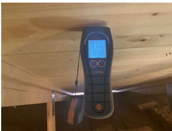
Bild 6: Utvändigt, Vind, Fuktkontroll utförd under gränsvärde se bilaga 4.....
