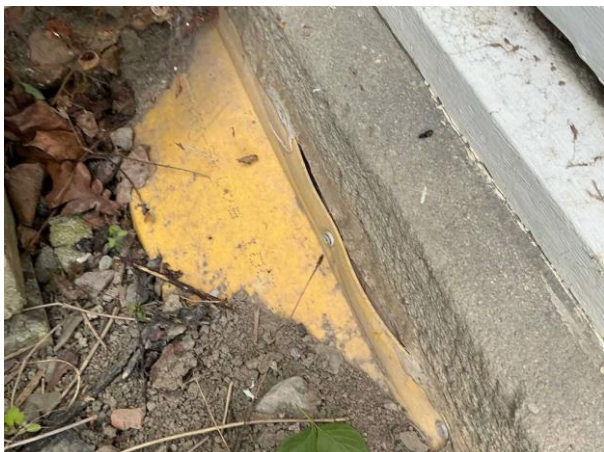
Bild 1: Utvändigt, Grundmur/Hussockel, Topplisten är synlig samt är den inte tät mot grundmuren Sprucken topplista noterades
