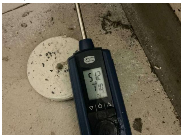
Bild 11: - Invändigt, Källarplan, Fuktkontroll utförd under gränsvärde se bilaga 4
