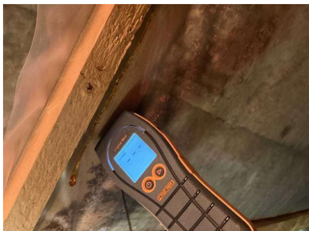
Bild 7: - Utvändigt, Vind, Fuktkontroll utförd under gränsvärde se bilaga 4
