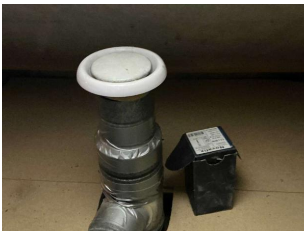
Bild 8: - Utvändigt, Vind, Delvis Parallelliserade /snedtaken besiktningsbart utrymme, se riskanalys Underlagstakets insida...
