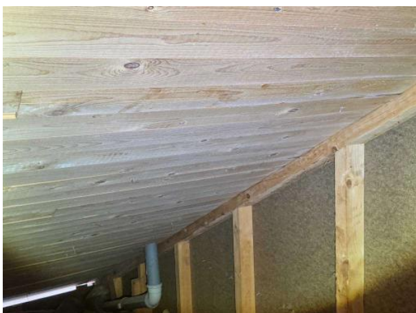
Bild 3: - Utvändigt, Vind, Fuktbläck på golvet under luftning till avlopp Lokal mikrobiell påväxt på underlagstaket Se riska...
