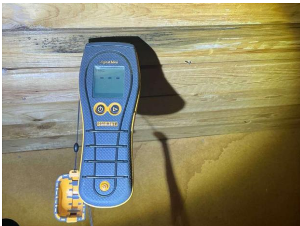
Bild 2: - Utvändigt, Vind, Fuktkontroll utförd under gränsvärde se bilaga 4
