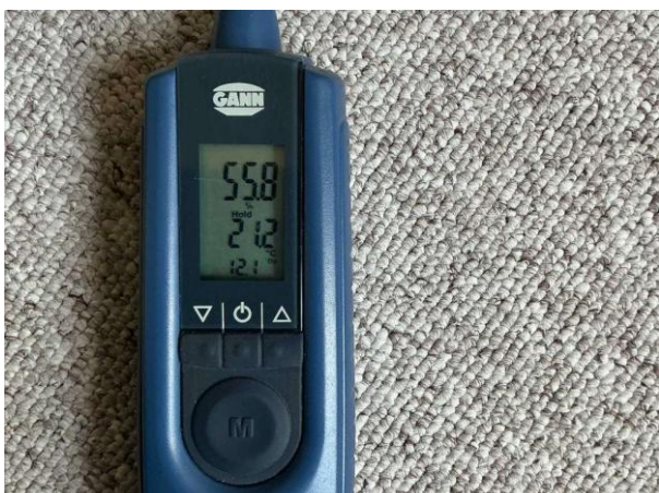
Bild 5: Invändigt, Entréplan, Fuktkontroll utförd under gränsvärde se bilaga 4
