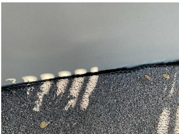
Bild 1: - Utvändigt, Grundmur/Hussockel, Topplisten saknas till dräneringen Spricka noterades i grundmuren
