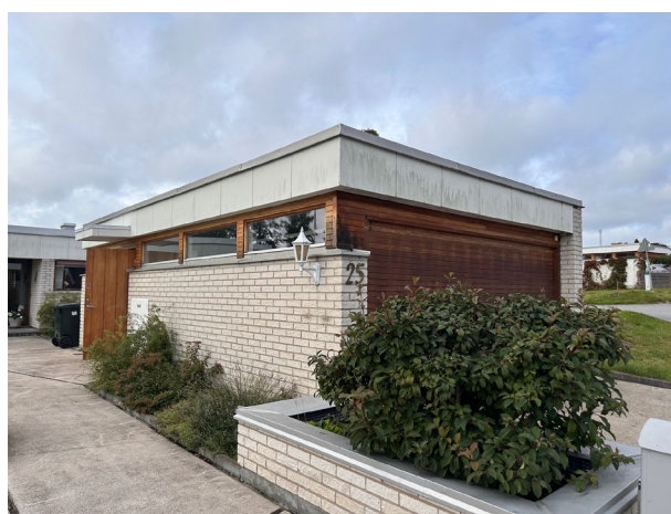
"Fristående garage med pannrum/tvättstuga"
