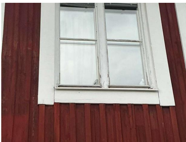
Bild 4: - Utvändigt, Fönster, Färgsläpp och torrsprickor noteras på fönster
