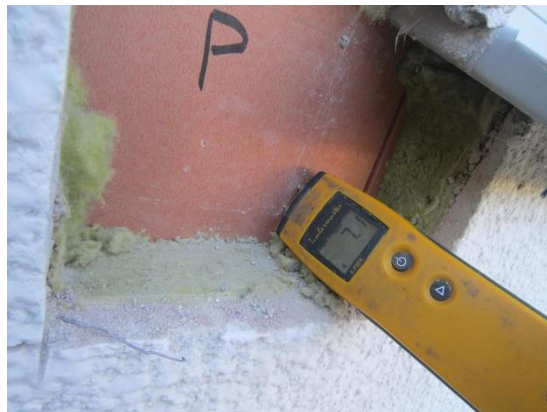
Foto 24 Ingen synlig missfärgning på yttre gipsskiva vid fönsterbleck
