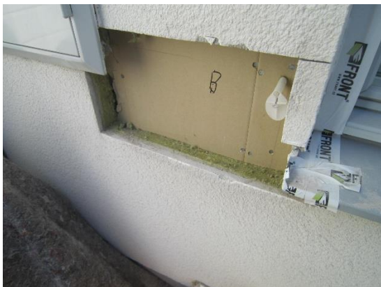
Foto 5 Inga synliga tecken på fuktpåverkan
