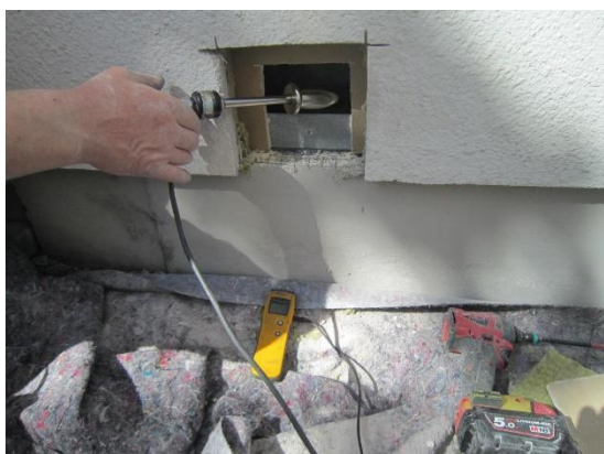
Foto 11 Fuktmätning i stående regel
