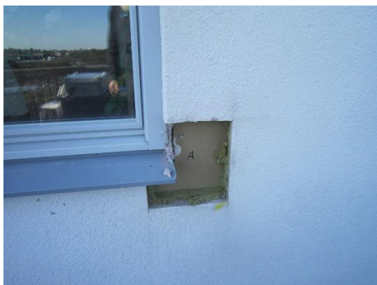
Foto 2 Inga synliga tecken på fuktpåverkan
