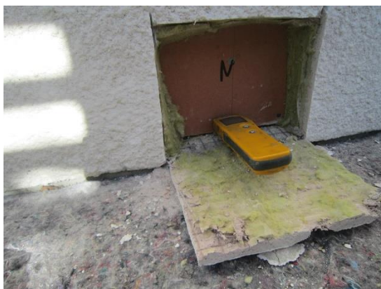
Foto 30 Ingen synlig missfärgning på yttre gipsskiva
