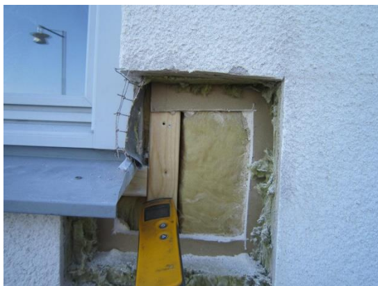
Foto 4 Inga synlig påverkan på bakomliggande träregelverk.
