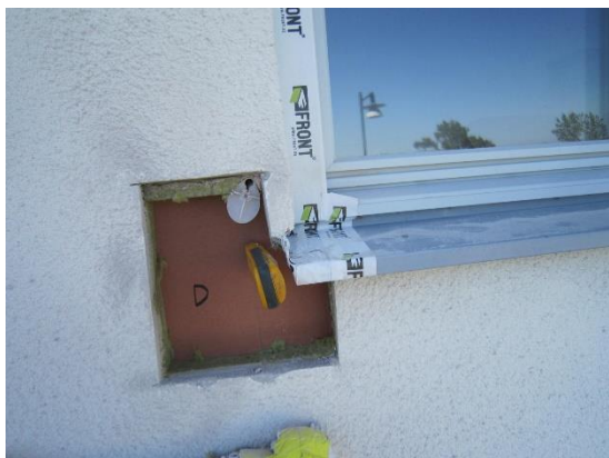
Foto 9 Inga synlig missfärgning på yttre gipsskiva
