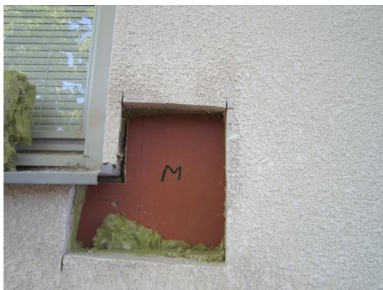
Foto 28 Ingen synlig missfärgning på yttre gipsskiva vid fönsterbleck
