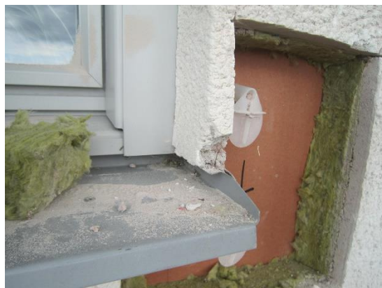
Foto 26 Ingen synlig missfärgning på yttre gipsskiva vid fönsterbleck
