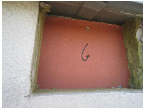
Foto 16 Inga synlig missfärgning på yttre gipsskiva
