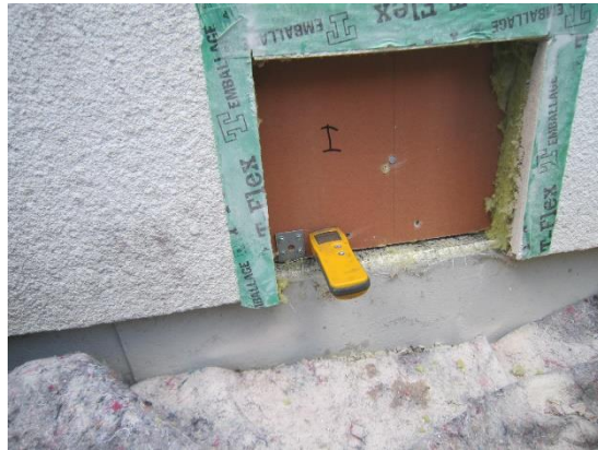
Foto 20 Inga synlig missfärgning på yttre gipsskiva
