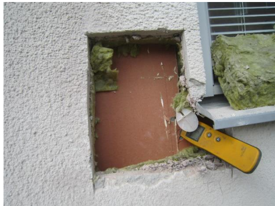
Foto 22 Inga synlig missfärgning på yttre gipsskiva
