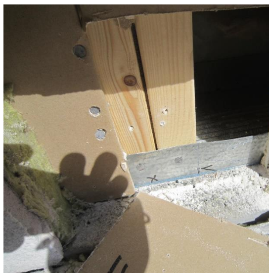
Foto 14 Inga synlig påverkan på bakomliggande träregelverk.
