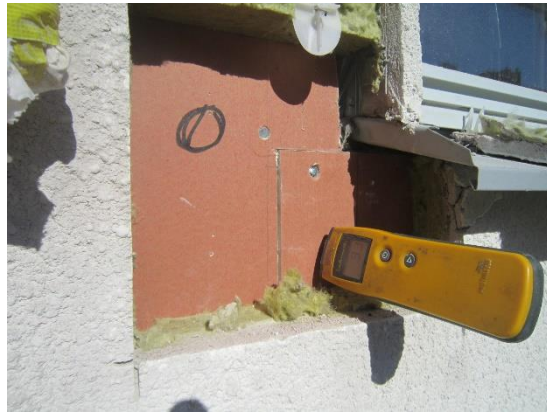
Foto 32 Ingen synlig missfärgning på yttre gipsskiva vid fönsterbleck
