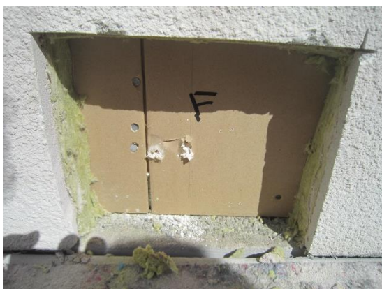
Foto 13 Inga synlig missfärgning på yttre gipsskiva
