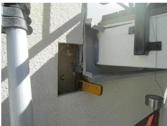
Foto 7 Inga synlig missfärgning på yttre gipsskiva
