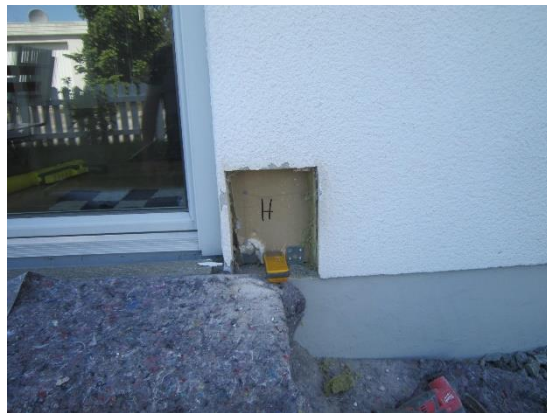
Foto 18 Inga synlig missfärgning på yttre gipsskiva
