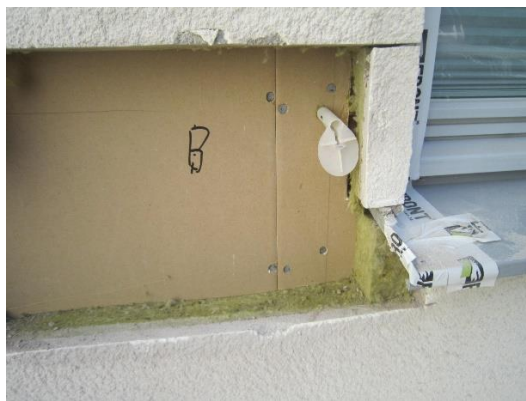
Foto 6 Inga synliga tecken på fuktpåverkan
