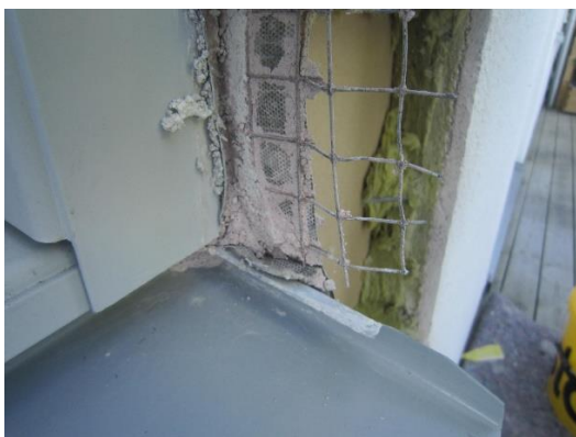
Foto 3 Tätning finns mellan fönster och puts
