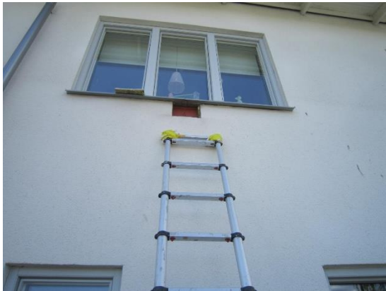
Foto 15 Provhål under delat fönsterbleck på övervåningen
