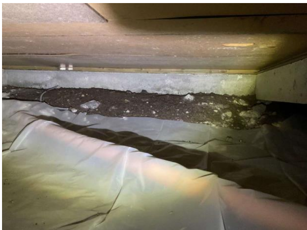
Bild 1: Utvändigt, Grund, Uteluftventilerad kryppgrund Bristfälligt utlagd Fuktavvisande plast mot kanterna på kryppgrund marken Fukt noteras på markbädden
