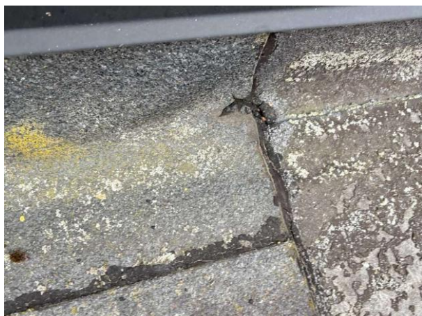
Bild 7: - Utvändigt, Yttertak, Äldre tak, spricka i takpappen ovan garaget
