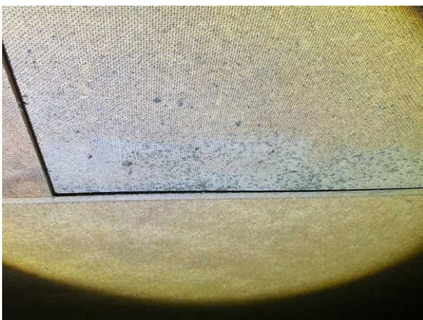
Bild 5: - Utvändigt, Vind Lokal mikrobiell påväxt
