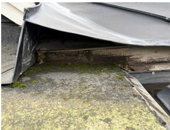
Bild 8: - Utvändigt, Yttertak, Äldre tak, takfotsbrädan från utbyggnaden ligger på garagetaket
