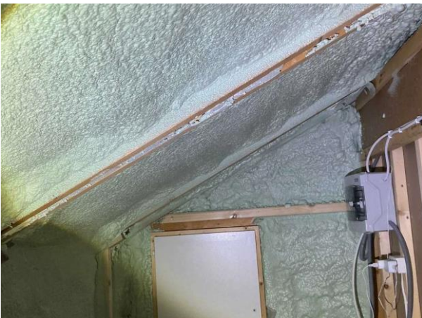
Bild 5: - Utvändigt, Vind, Parallelliserade /snedtak förekommer Sidovind är isolerad med closed cell sprutisolering Del a...
