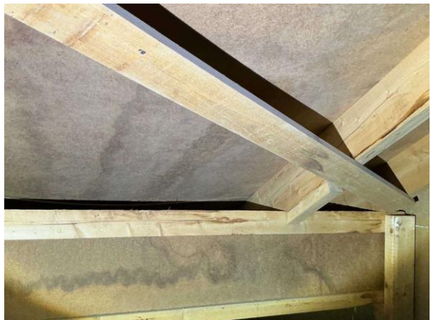
Bild 6: - Utvändigt, Vind, Parallelliserade /snedtak förekommer Sidovind är isolerad med closed cell sprutisolering Del a...
