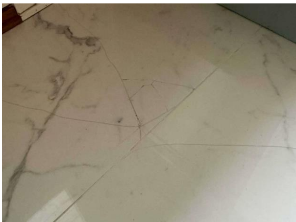
Bild 9: - Invändigt, Entréplan, Skada i spishäll Tätbotten saknas i diskbänkskåpet Avloppsslang från diskmaskin ej klamrad i skå...
