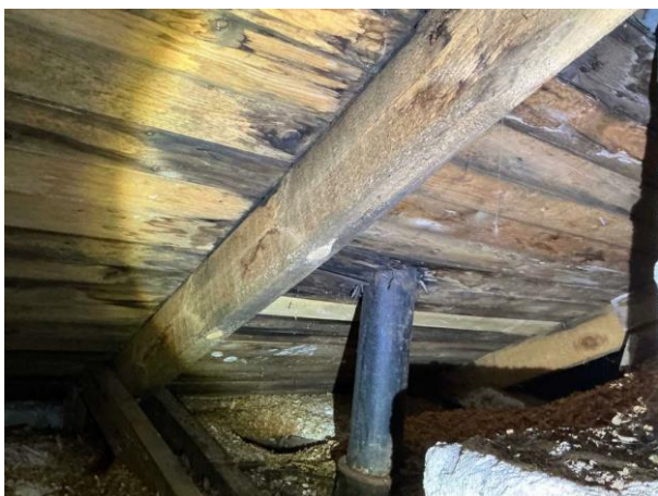
Bild 7: - Utvändigt, Vind, Huset är självdragsventilerat, se riskanalysen Det noterades mikrobiell påväxt på vindens underla...
