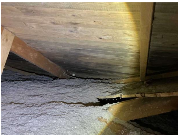
Bild 10: - Utvändigt, Vind, Huset är självdragsventilerat, se riskanalysen Det noterades mikrobiell påväxt på vindens underla...
