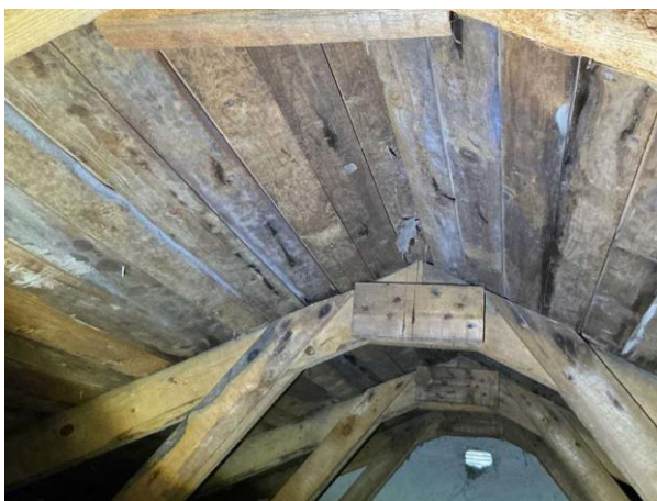
Bild 8: - Utvändigt, Vind, Huset är självdragsventilerat, se riskanalysen Det noterades mikrobiell påväxt på vindens underla...
