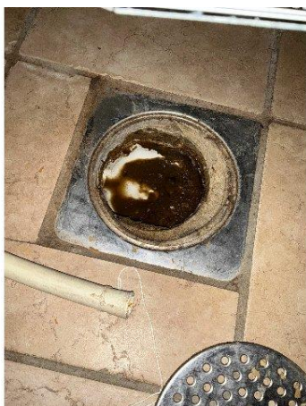
Bild 1: Invändigt, Entréplan, Golvbrunnens anslutning är dold av sättbruk
