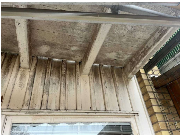
Bild 9: - Utvändigt, Balkong, Balkong med räcke och golv av plåt. Bjälklag med så kallade förlängda golvåsar.
