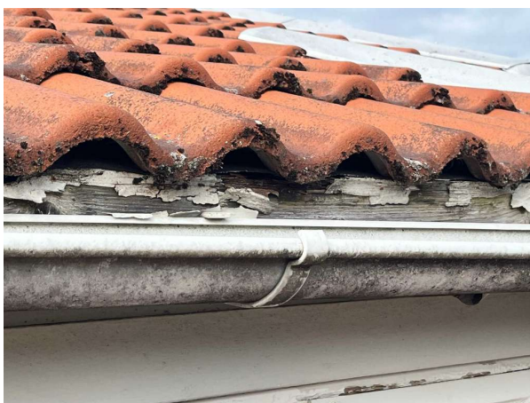
Bild 4: Utvändigt, Tak, Omfattande färgsläpp och rötskador noteras på fotbräda.
