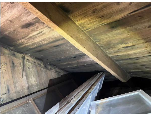
Bild 5: Utvändigt, Vind, Påväxt/missfärgningar på yttertakets insida noteras, vilket bör ses över för att minska risken ...
