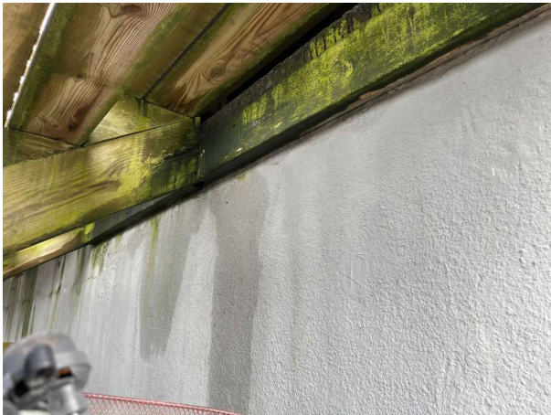
Bild 15: Utvändigt, Altan, Altanens bärlina bedöms vara monterad i kontakt med fasaden och fuktrosor noteras på vägg under b...
