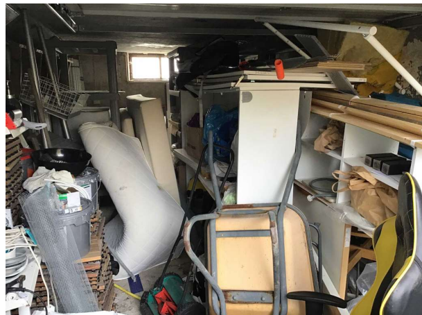
Bild 24: Invändigt, Vidbyggd del, Utrymmet var vid besiktningstillfället belamrat varför det ej gått att kontrollera på ett fullgot...
