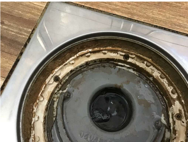
Bild 23: - Invändigt, Plan 1, Brunnsduk sticker ut under klämring. Se Riskanalys.
