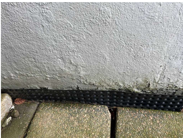
Bild 5: Utvändigt, Dränering/Dagvatten, Husets dränering är av okänd ålder och utförande. Lokalt noteras fuktisolering av typ Platonmatta...
